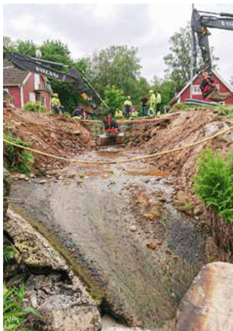
Vandringshinder i form av en vägtrumma åtgärdas. Foto: Håkan Bengtsson.
