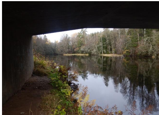
Södra sidan runt brofundament, även under bron.
