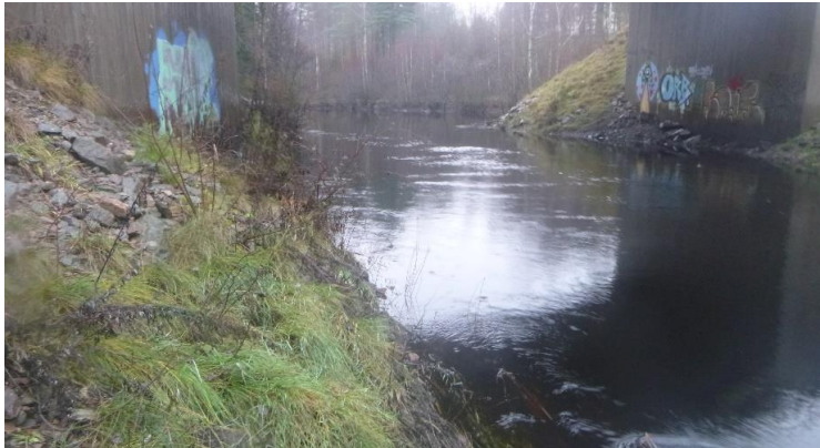
0-10 m nedströms landsvägsbron, uppströms gammal bro.
