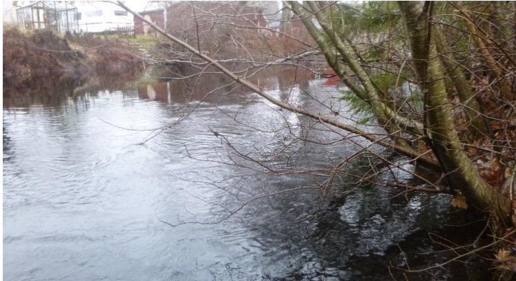
0-10 m uppströms brofundament på östra sidan.
