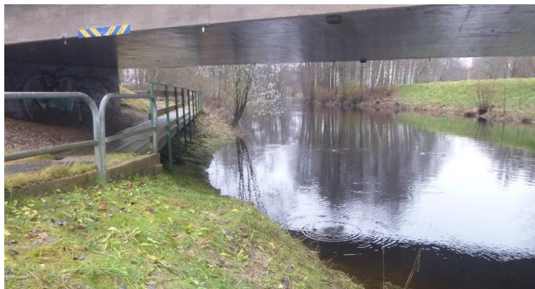
Under första bron, uppströms sett.
