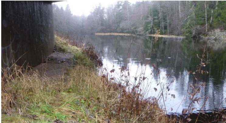
Södra sidan runt brofundament, även under bron.
