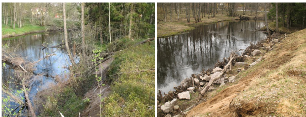
Figur 7 och 8. Erosionsbranten sedd mot öster före och efter byggande av erosionsskyddet 2008.
