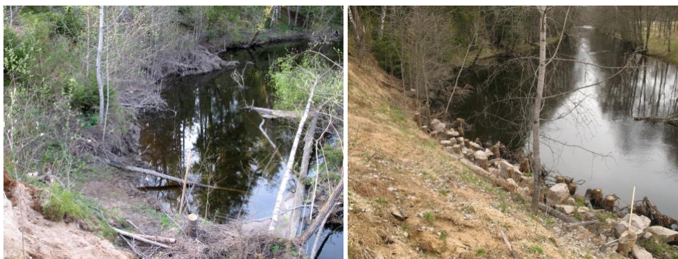
Figur 5 och 6. Erosionsbranten sedd mot norr före och efter byggande av erosionsskyddet.
