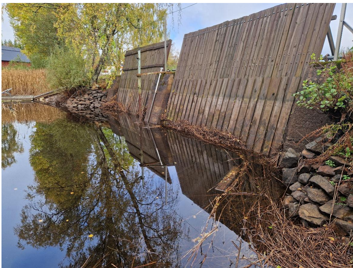
Figur 30. Vandringshindret i Spångån som utgörs av ett dämme i trä.
