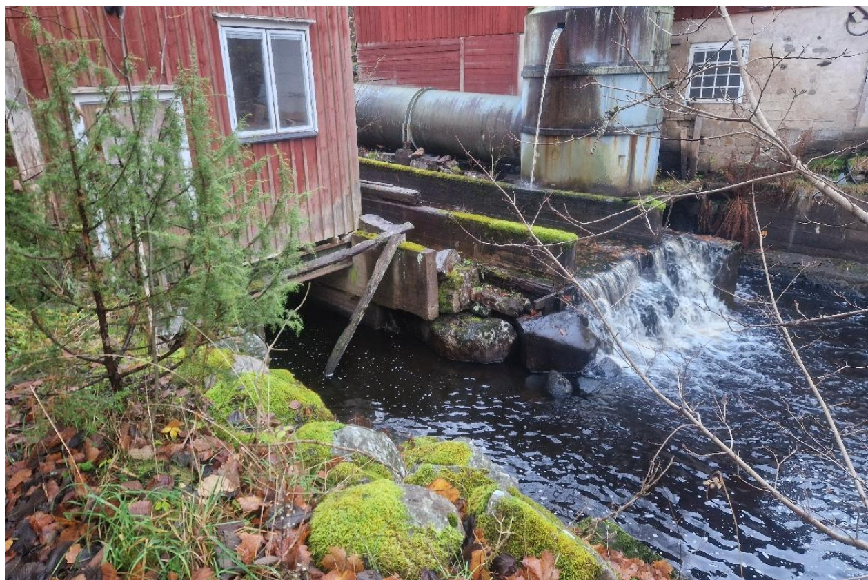
Figur 10. Vandringshinder 1 i Drägvedsån som utgörs av en damm.
