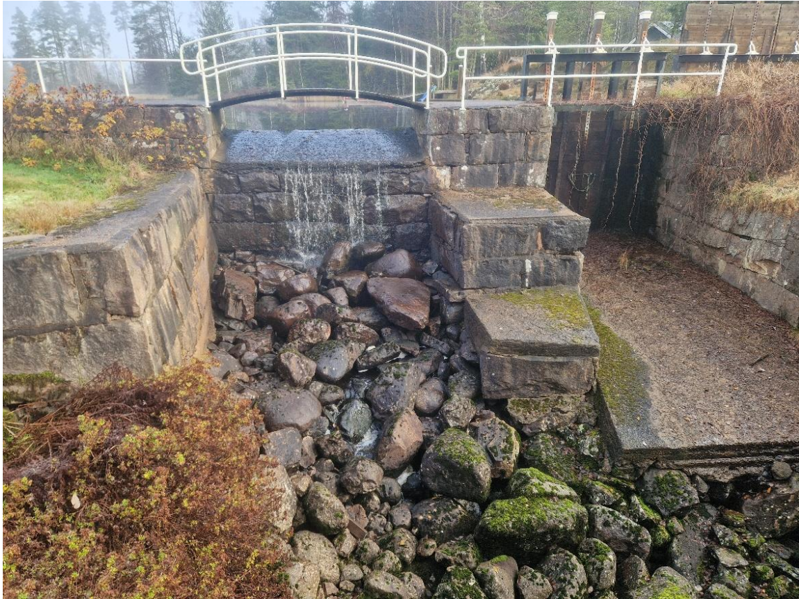
Figur 13. Vandringshinder 2 som utgörs av en damm med en torrlagd sidofråga.
