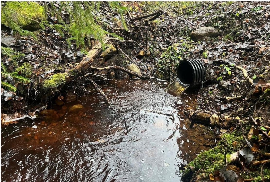
Figur 41. Vandringshinder två som utgörs av en vägtrumma.
