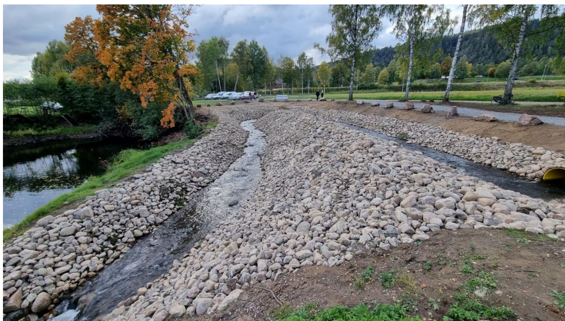
Figur 15. Fiskvägen i Vist, detta omlöp invigdes hösten 2022. Och ger fisken en möjlighet att simma förbi det första kraftverket uppströms Åsunden.
