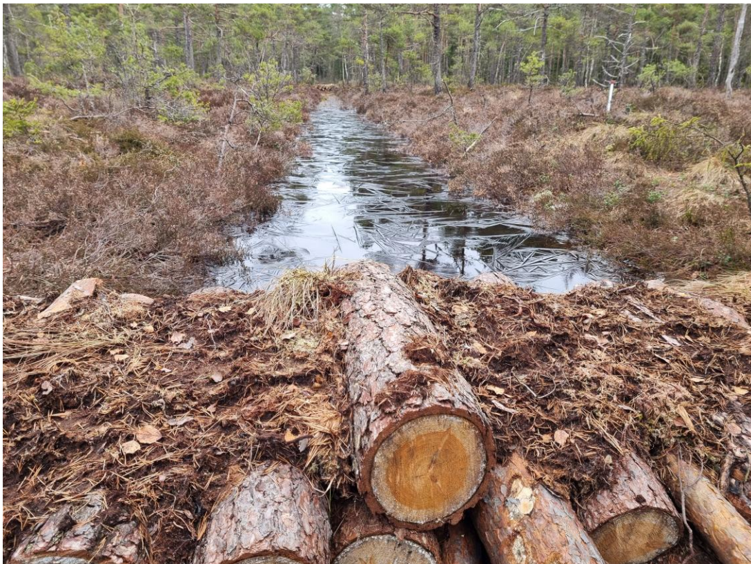
Figur 19. En av de pluggar som anlades i början på 2024, inom ett LONA projekt som vattenrådet drivit tillsammans med Tranemo kommun.
