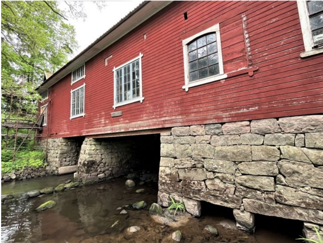
Figur 8. Kvarnens utloppskanal med fina naturstensmurar.
