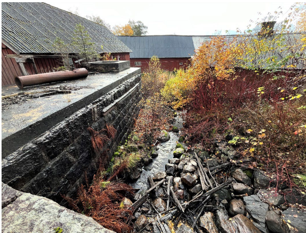
Figur 30. Inbyggd intagskanal med öppen turbinsump längst bort i bild. Byggnaden t v är sågverket och rakt fram i bild ligger ladugården.
