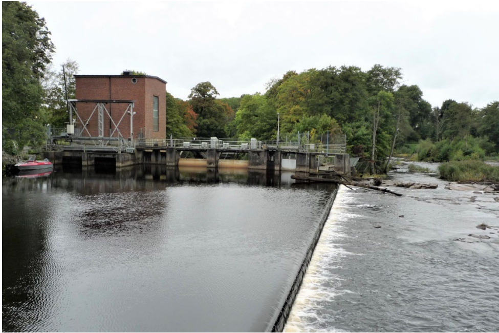
Figur 5. Hertings kraftverk från 1943 t v i bild. Skibordens vatten rinner över till den återöppnade huvudfåran.
