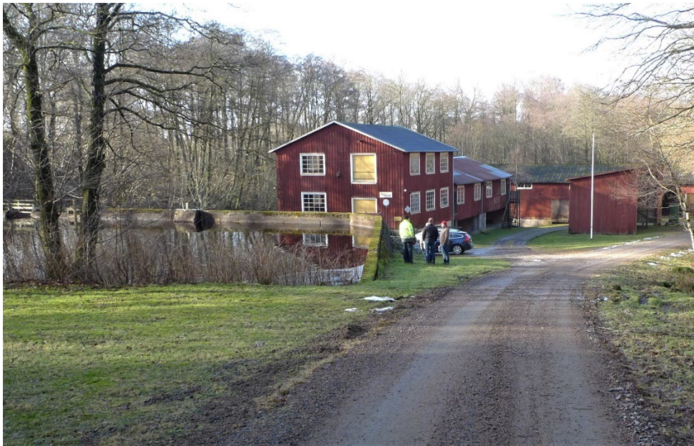
Figur 17. Hålldamm med krön av betong syns t v. Närmast dammen ligger kvarnen och därefter sågverket.
