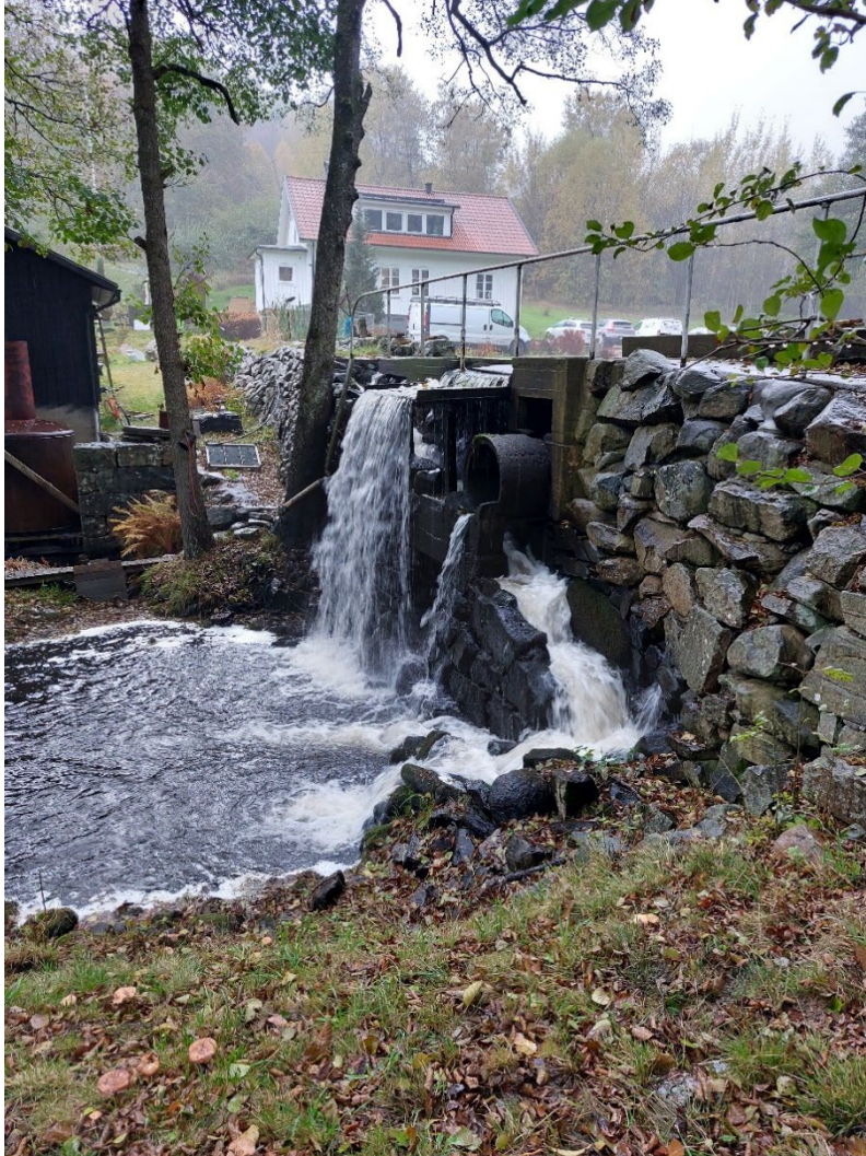
Figur. Dammen med en fiskväg till höger. Till vänster skymtar man turbinhuset och även turbinsumpen i stål.
