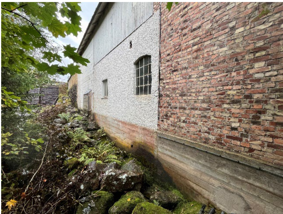
Figur 49. Längs frivattenfåran syns olika årsringar i byggnaden och i bakgrunden syns dammen som är tillverkad av huggen natursten
