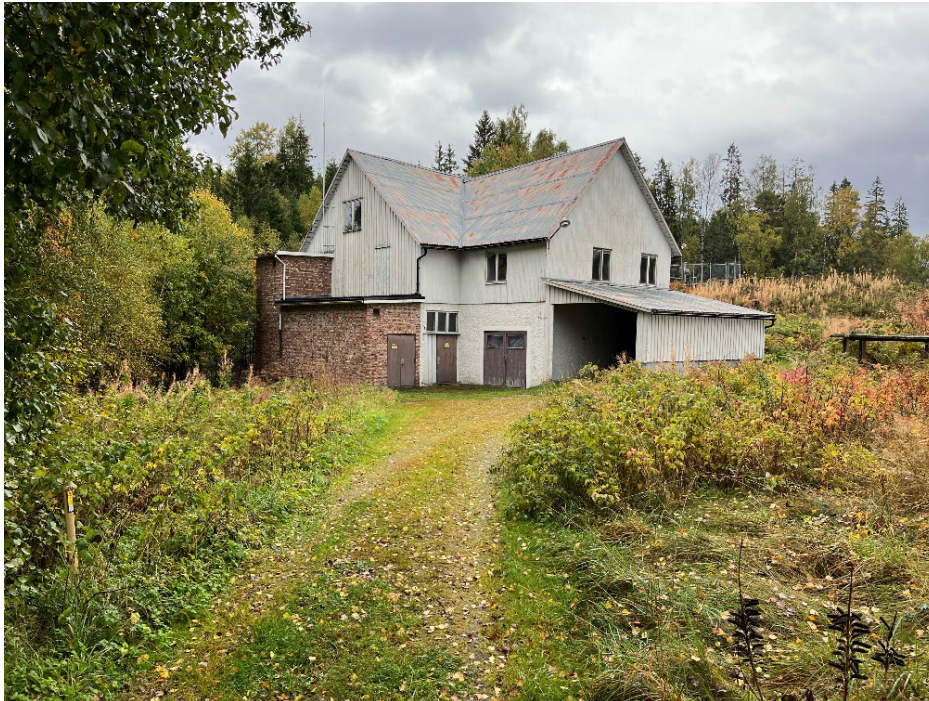
Figur 46. Ödegårdets kvarn och kraftverk byggt ca 1910. Den vidbyggda konstruktionen i tegel är från mitten av 1940-talet och inrymde fram till 2014 ett 10 kV-ställverk för centralorten Älvsered
