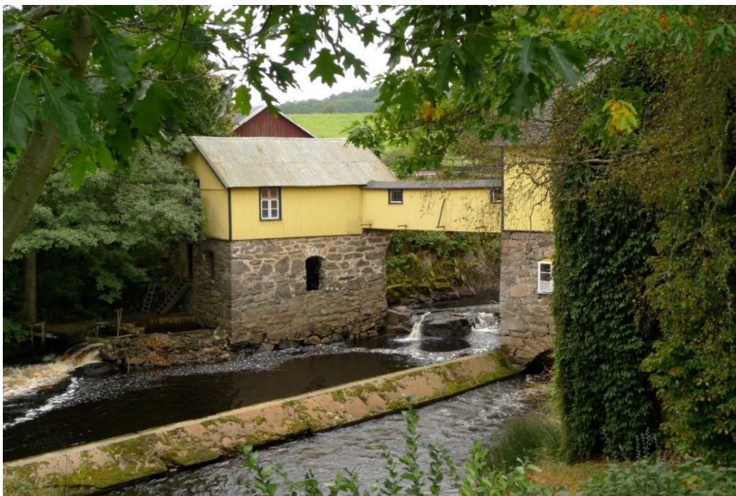
Figur 20. Bygganden till vänster är en äldre hjulkvarn där utloppskanalen är en del av en laxfälla. Vid den högra byggnaden syns utloppskanalen kantad med en betongmur.
