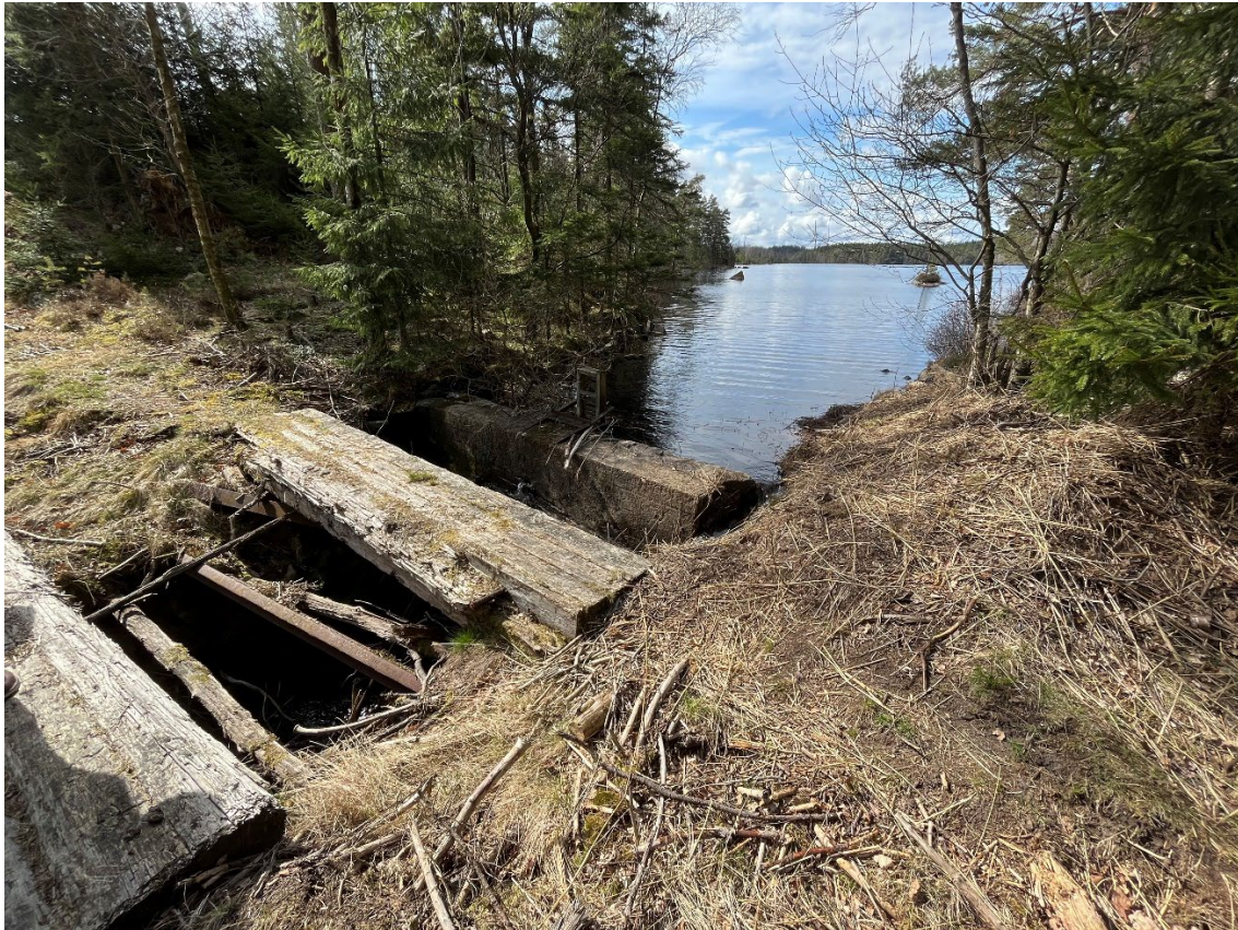
Figur 33. Bredsjöns utlopp med dammvall av betong från 1925. På bilden syns även resterna efter en balkbro. Foto Länsstyrelsen Halland 2022.
