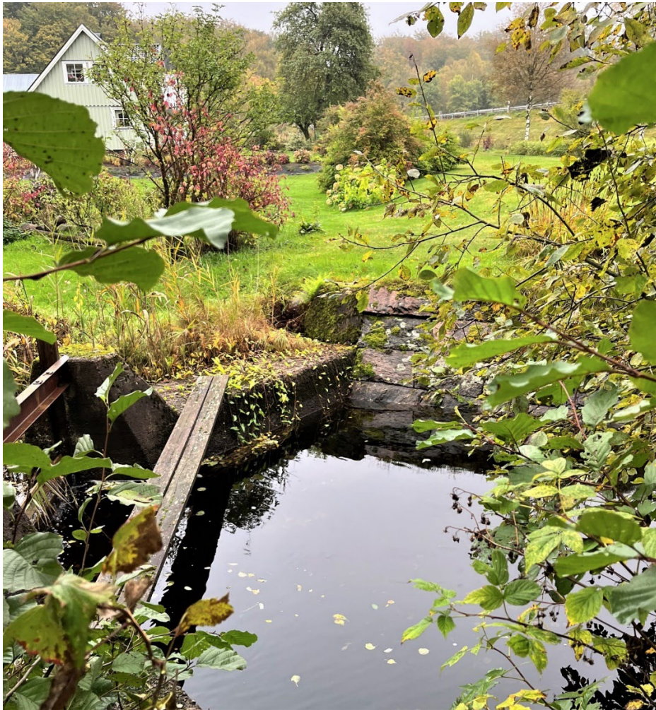
Figur 26. Dämme byggt av huggen natursten och betong vid sjöns Svartens utlopp.
