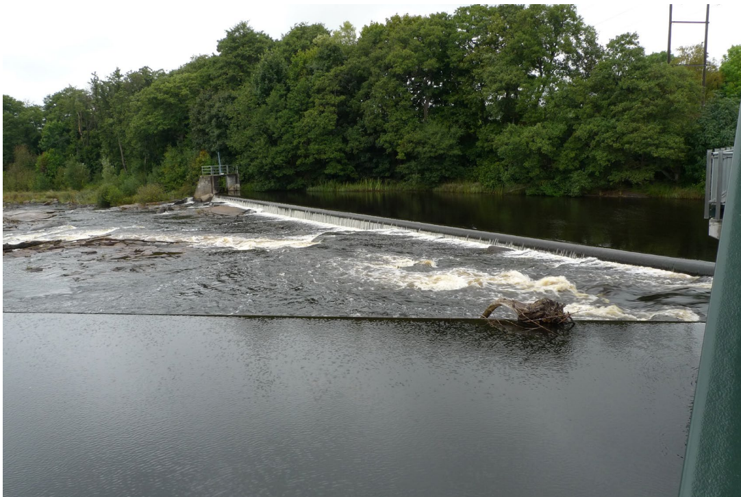
Figur 2. Den nya fiskvägen vid Herting kraftverk ligger i den ursprungliga åfåran och är en naturliknade fiskväg av typen dubbelt inlöp.
