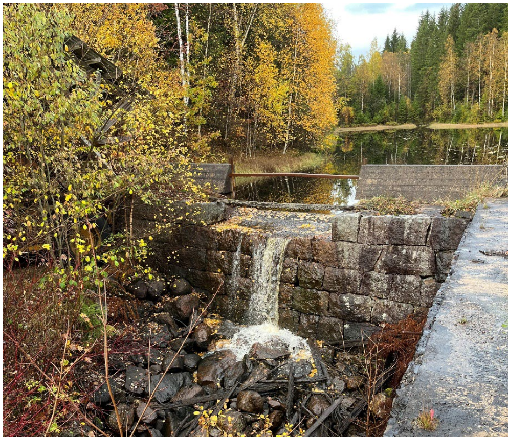
Figur 31. Damm byggd med huggen natursten från stenbrottet vid Lysesten.
