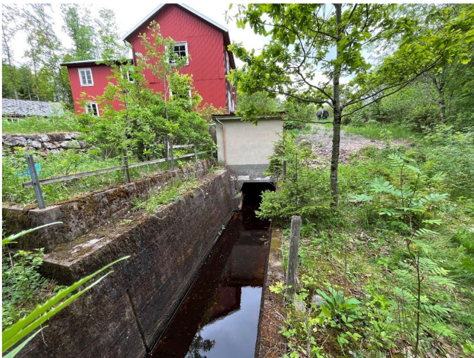
Figur 15. Den vita betongbyggnaden inrymmer kraftverket för elproduktion från 1940. På bilden syns också utloppskanalen.
