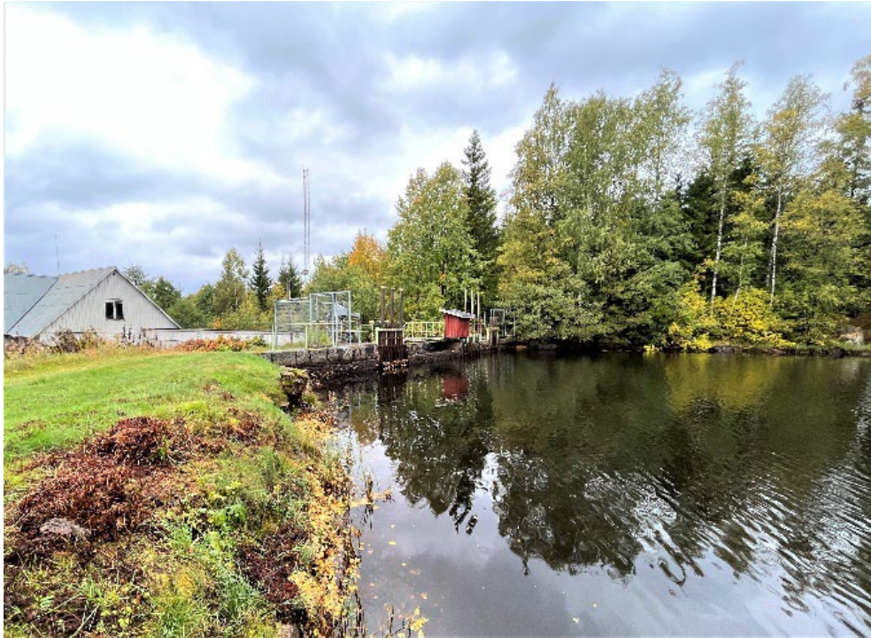
Figur 48. Damm av huggen natursten och överbyggd intagskanal.
