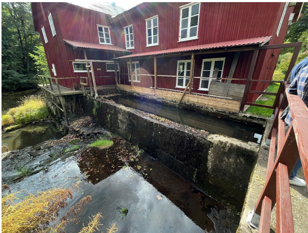
Figur 11. Intagskanal som även fungerar som skibord vid högre vattenföring.
