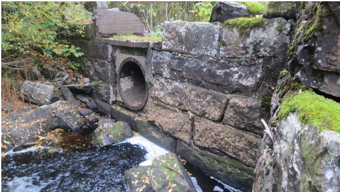
Figur. Rester av tuben och intaget till kraftverket.
