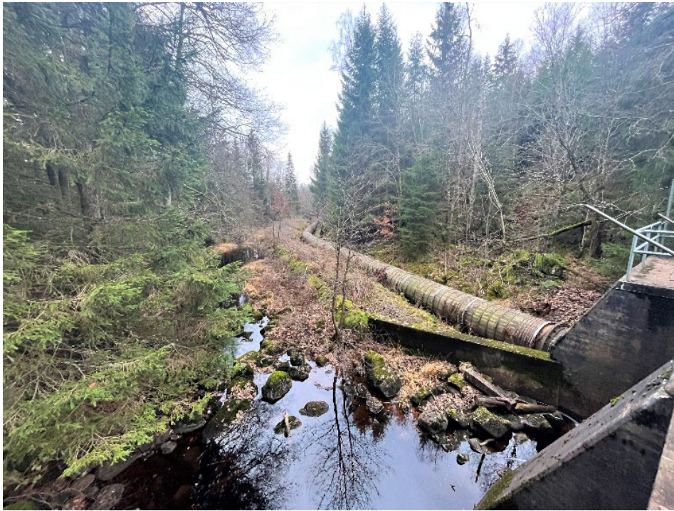
Figur 43. Damm i betong och den 108 meter långa trätuben ner till kraftverket.
