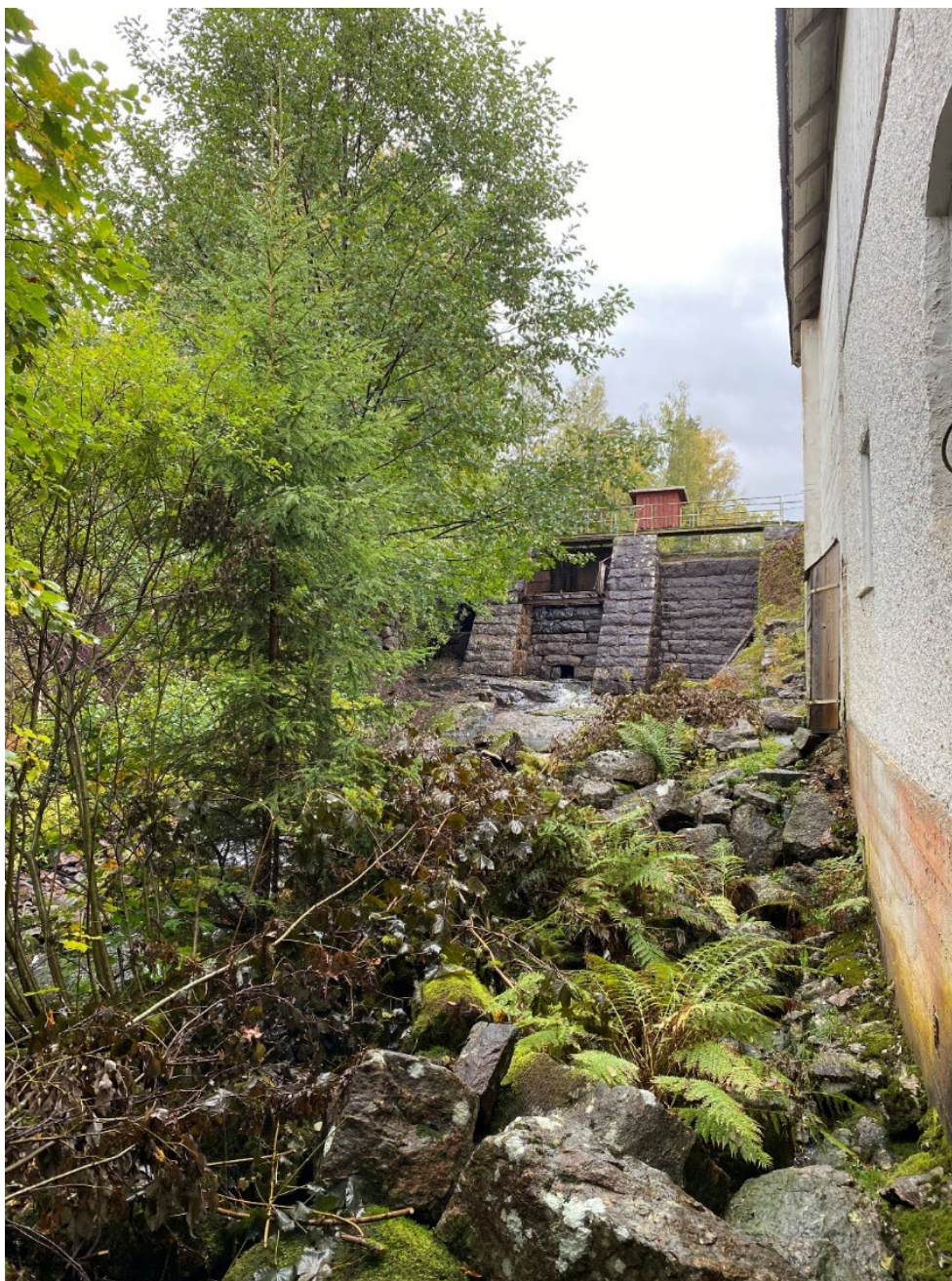
Figur 45. Dammen vid Ödegärdet kraftverk.
