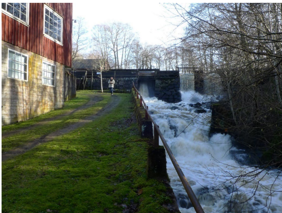
Figur 18. Damm av huggen natursten med krön av betong och kvarnen till vänster i bild.
