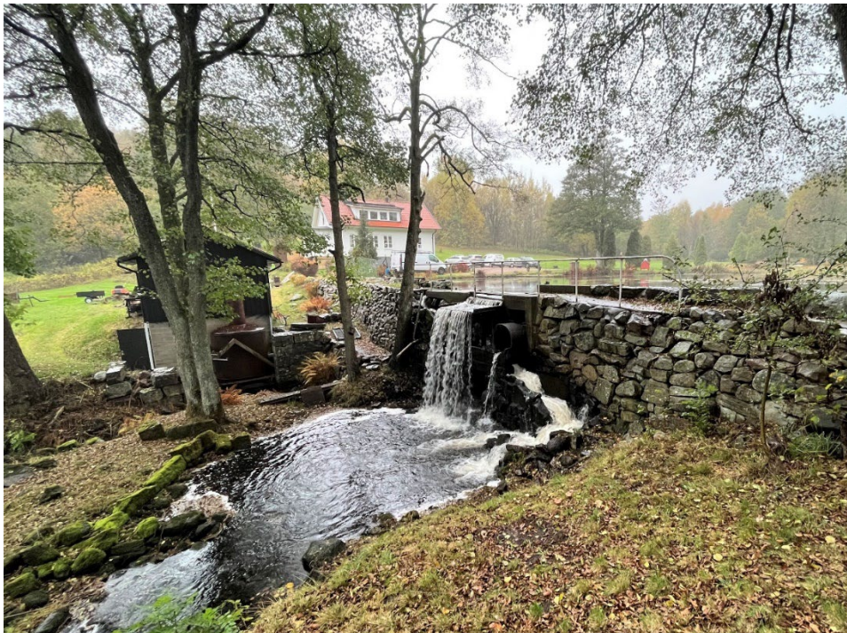
Figur 12. Dam av tuktad natursten med en fiskväg till höger. Längst till vänster syns kraftverket på samma plats som den rivna kvarnen. Framför kvarnens gavelsida syns turbinsumpen i stål. I bakgrunden skimtar den renoverade mjölnarbostaden.
