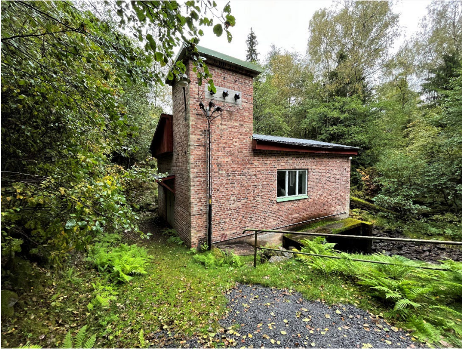
Figur 41. Strömma Kraftverk med sitt karaktäristiska utledningstorn. Inne i kraftverket finns en ursprunglig Francis dubbelturbin från Hällarydsverken och en generator från Asea. Den gamla instrumentpanelen finns kvar men har kompletterats med moderna reglage och styrning.
