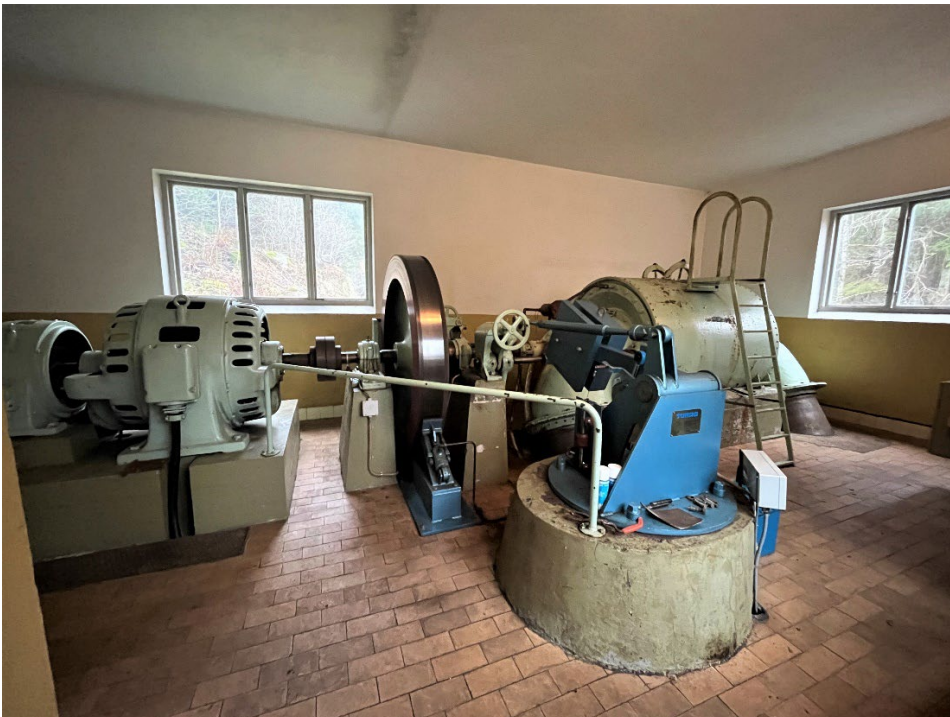
Figur 42. Ursprunglig Francis dubbelturbin från Hällarydsverken och generator från Asea.
