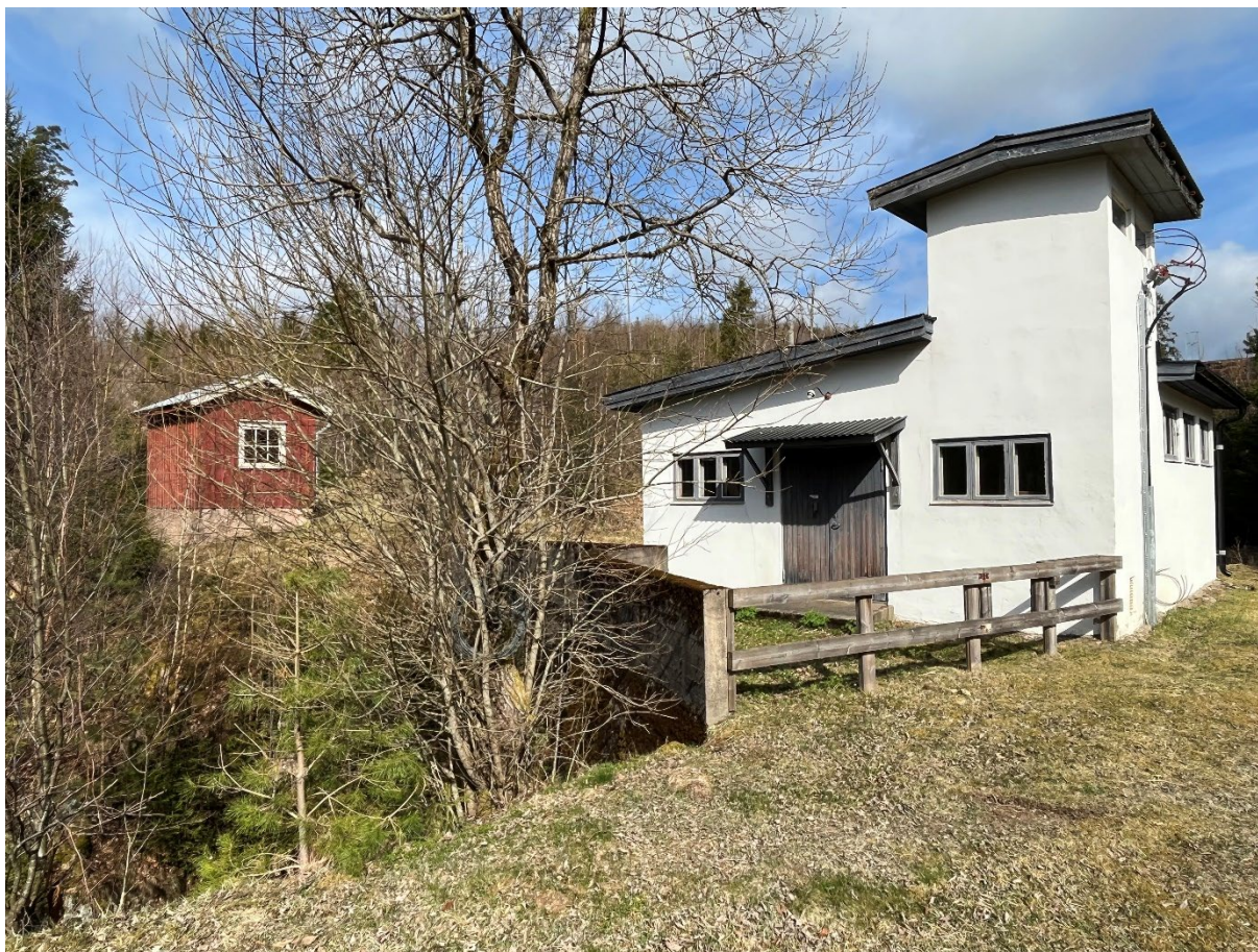
Figur 38. Iwarsfors kraftverk uppfördes 1935 med en tidstypisk funktionalistisk prägel. I den faluröda träbyggnaden till vänster förvarades smörjprodukter till maskinerna. Foto, Länsstyrelsen Halland 2022.
