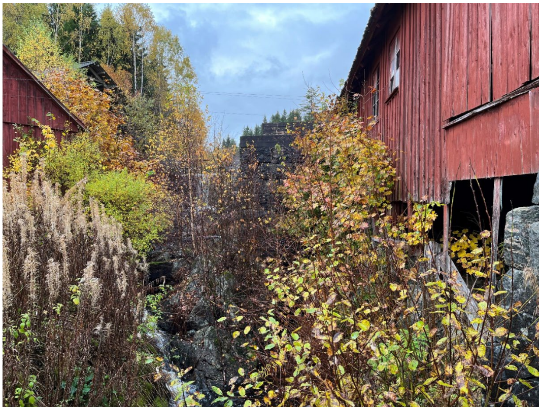
Figur. Byggnaden till höger är sågverket och längst bort i bild skimtar man dammen.
