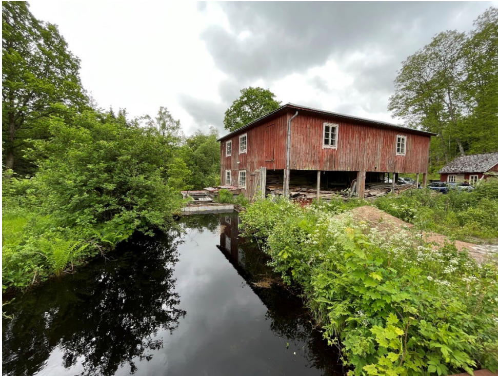
Figur 14. Intagskanal med kvarn- och sågverksbyggnad t h i bild.
