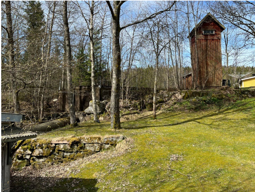
Figur 36. På dammkrönet syns transformatorstationen och till vänster syns dammvallen i betong och glasfibertuben. Foto, Länsstyrelsen Halland 2022.
